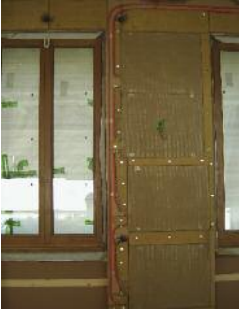
5 + 6 Eine Alternative zur verputzten Wandflächenheizung: Lehmplatten mit wasserführenden Heizleitungen – in rohem und fertigem Zustand.
