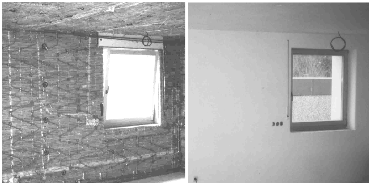
Abb. 7: Ausführungsbeispiel Wandheizsystem – hier Kupferrohrregister – im Bestand auf Innendämmung (vorher/nachher)
