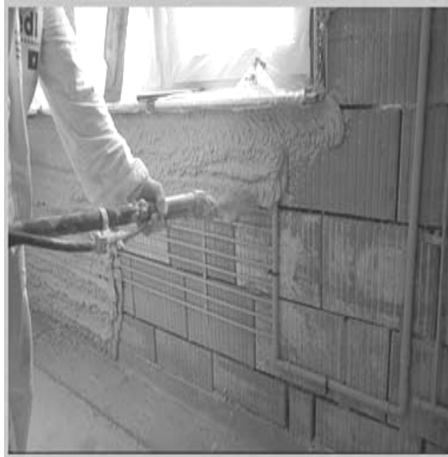
Abb. 6: Einlagige Putzverarbeitung mit Kalk-Gips-Putz
