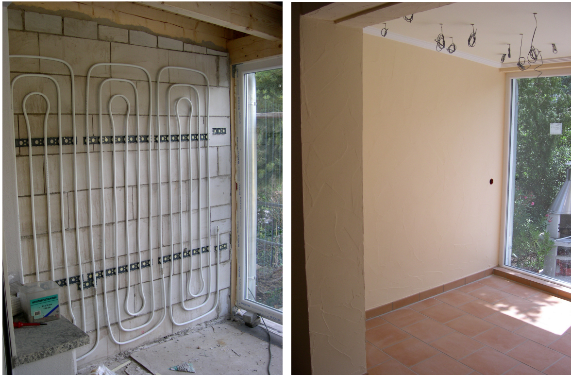
Abb. 9: Ausführungsbeispiel Wandheizsystem – hier Register aus Kunststoff-Aluminium Verbundrohren– bei einem Anbau an ein Bestandsgebäude (vorher/nachher)
